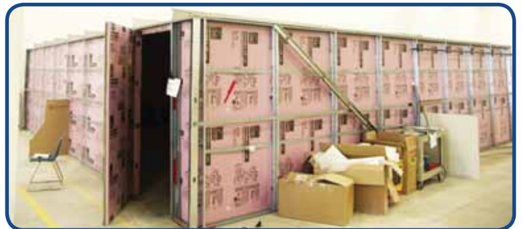
Photo : Salle de 93 m 2 (1000 pi 2 ) [9,75 x 9,75 x 2,5 m (32 x 32 x 8 pi)] construite pour le test décrit dans ce rapport.
